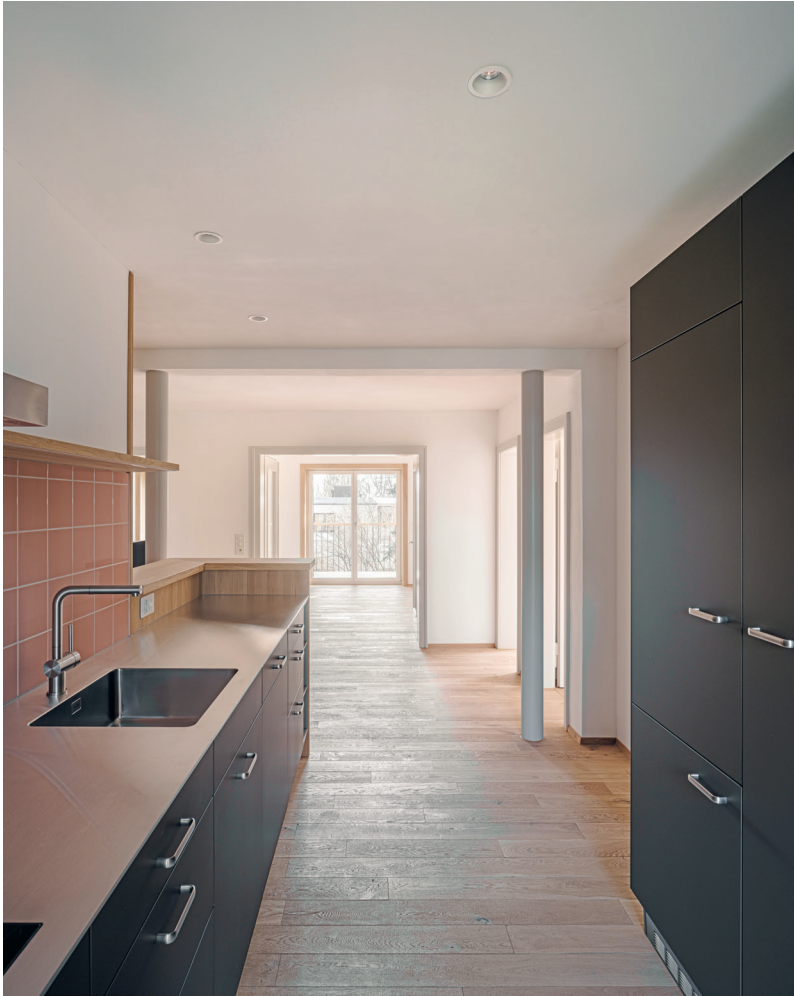
In den neuen Einbauküchen von Forster wurde auf jegliche Verklebungen verzichtet, um den sortenreinen Rückbau garantieren zu können.
